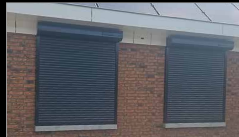
\ Installation contre le mur
